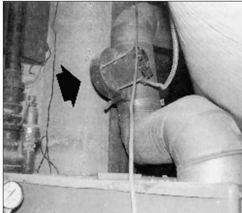
شکل ۶-۴ از جمله اجزای جانبی که بر روی دودکش نصب می‌گردد و باید کارکردشان در زمانیکه مشعل‌ها خاموش می‌باشند متوقف گردد.
